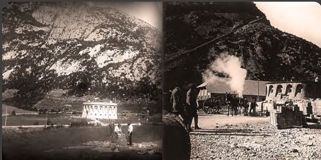
La Torreta del norte, antes y durante la construcción del Túnel Internacional del Somport
